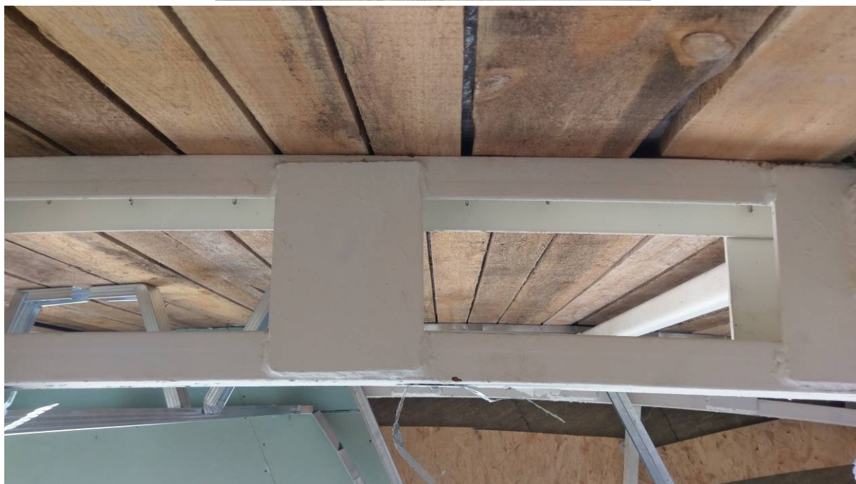
Рис. 3.6. Загальний вигляд каркасу покрівлі горища, що оглядалася, (квартири №132) – архівні фото станом на 2016-2017 роки.
