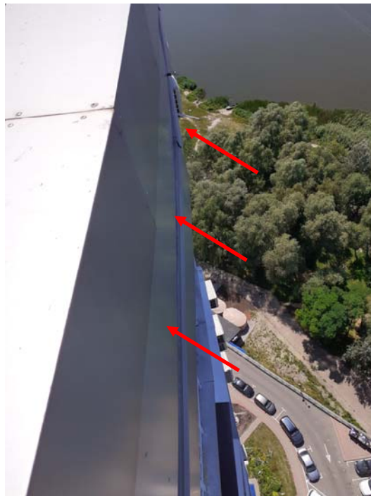
Рис. 3.14. Рекомендації по влаштуванню проектованої труби вздовж фасадів по осі А, К в рівні перекриття 24 поверху для вивішування альпіністів (варіант 2).
